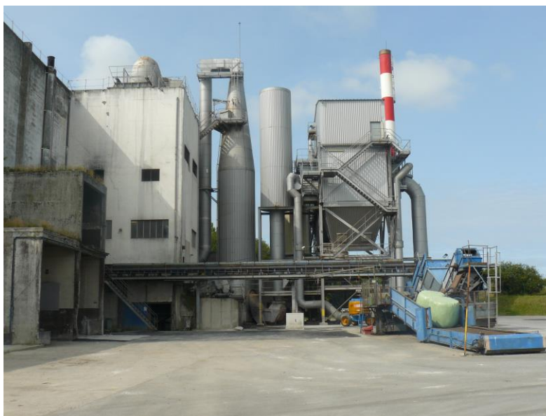
Usine d'incinération à Plouharnel
