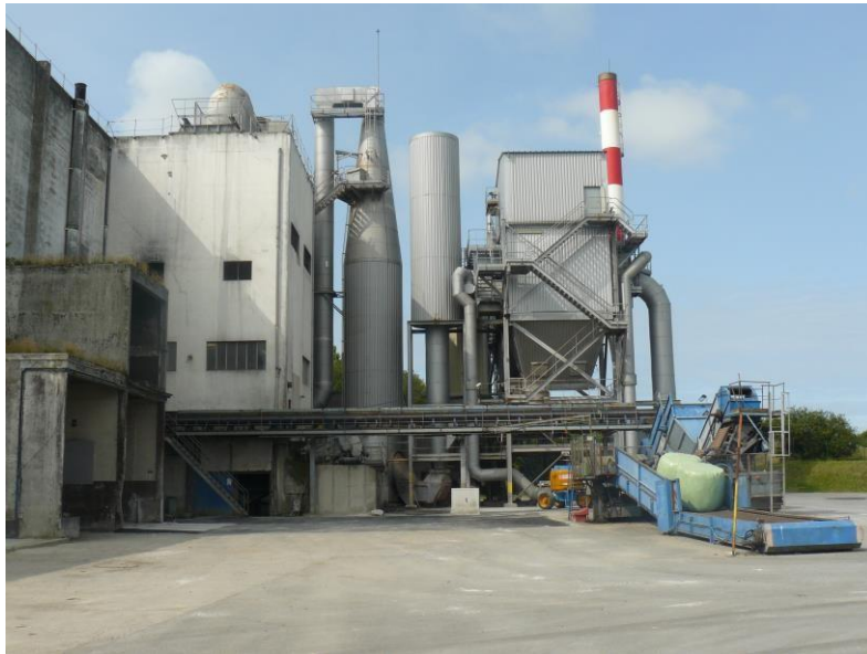
Usine d'incinération à Plouharnel
