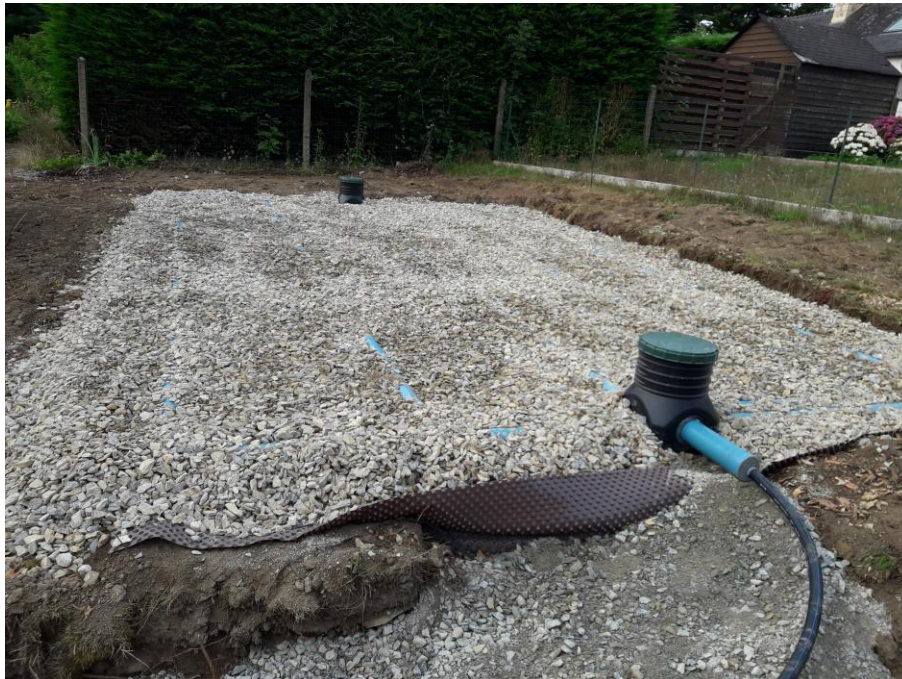
Figure 2 : Filtre à sable vertical non drainé 40 m 2
