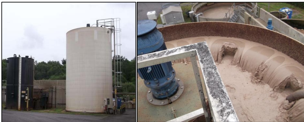
Figure 4 : Photos de la cuve d'hydrolyse de la STEP du Porzo
