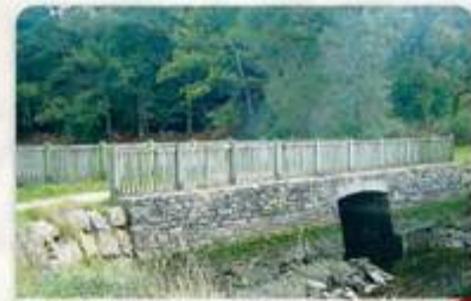
Le pont de Remoulin
