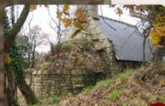
Four de Kerdrain 5
