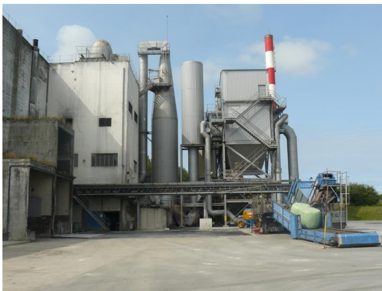
Usine d'incinération à Plouharnel
