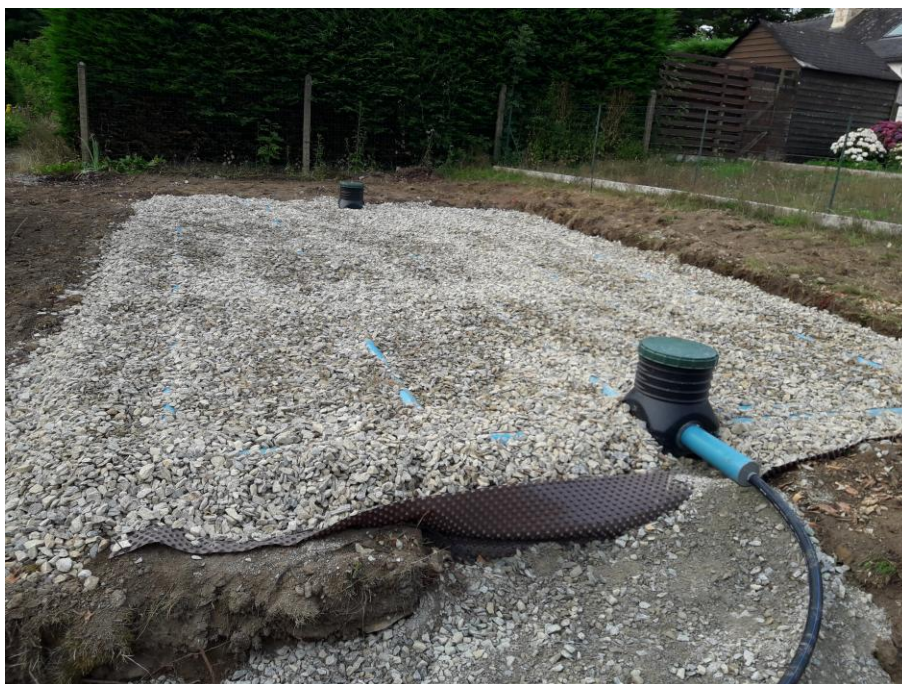
Figure 2 : Filtre à sable vertical non drainé 40 m 2
