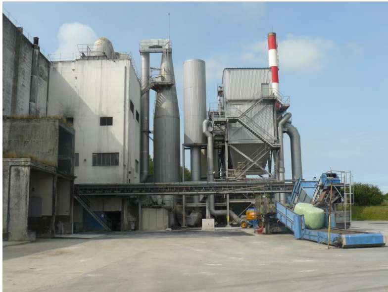
Usine d'incinération à Plouharnel
